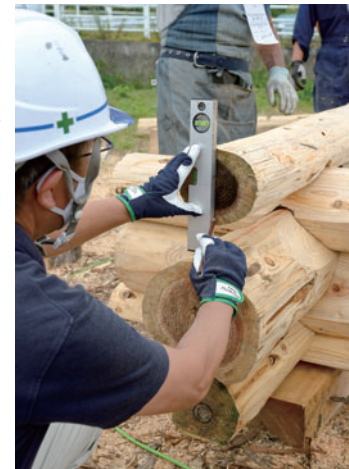
スクライバーを使い下のログの形を上ログに写し取るスクライビングは、ログハウスならではの作業。これがやってみると難しい!
